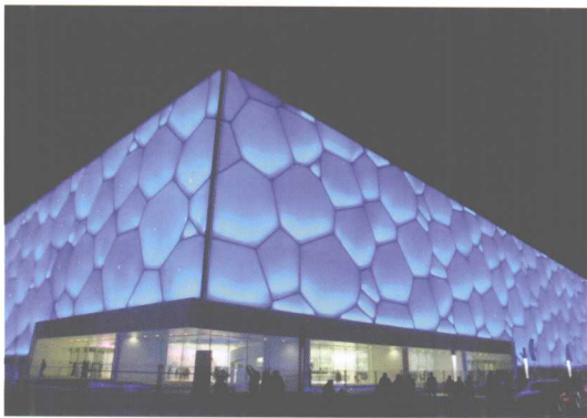
图 1-5 “水立方”的膜结构外观
