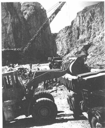
1980年龙羊峡电站导流洞 出口开挖工地（电站1987年并 网发电）
