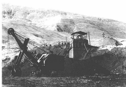
青海热水煤矿始建于1975年， 图为海塔尔矿点的9万吨斜井
