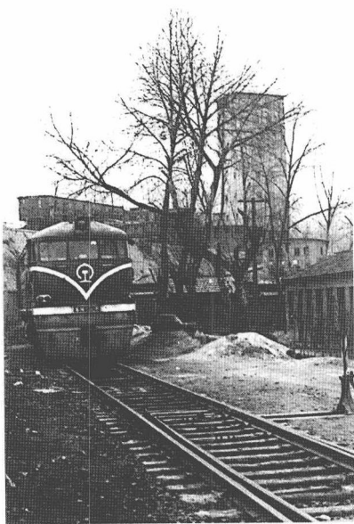
大通煤矿3号铁路专用线
