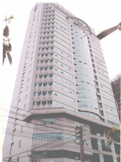
文昌北路上新近落成的贵州电信大楼。
