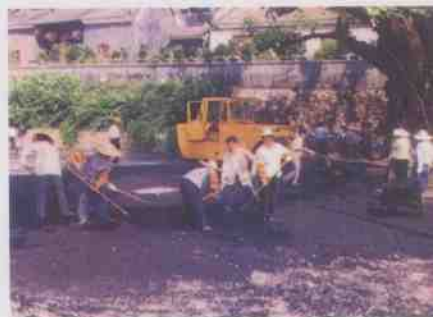
市政维修抢修现场
