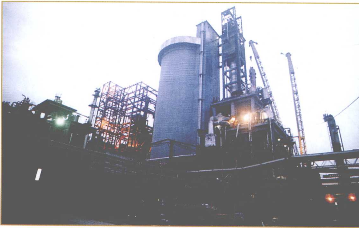
赤水天然气化肥厂通过技改，扩大了合成氨与尿素的生产能力。图为技改工程在施工中
