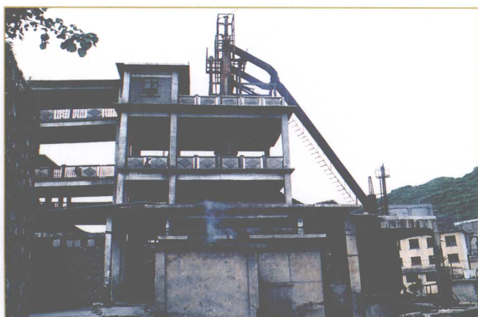
贵州福泉磷肥厂钙镁磷生产装置
