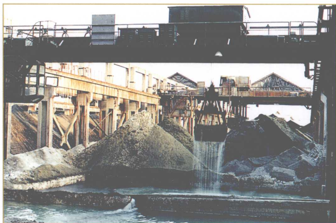
福泉磷肥厂高炉分厂生产现场
