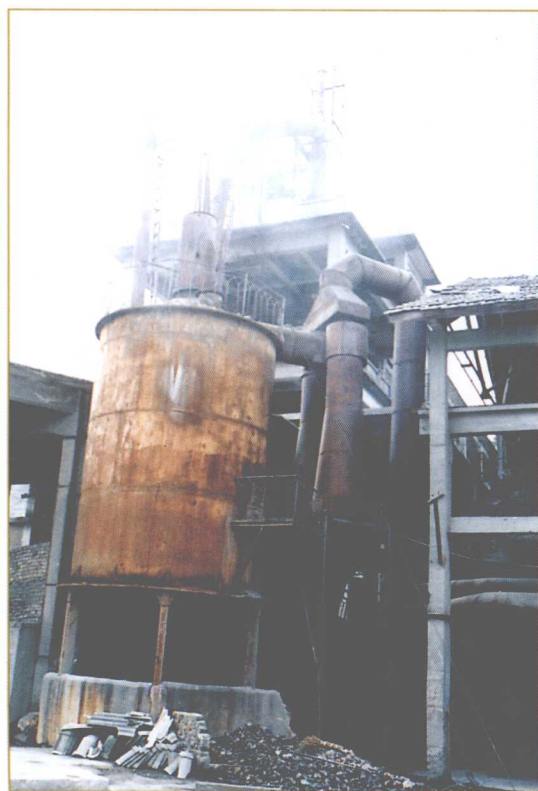
贵州福泉磷肥厂冶炼高炉
