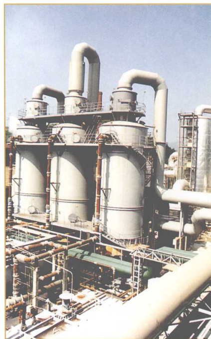
开磷集团息烽重钙厂年产 20万吨硫磺制硫酸的生产装置
