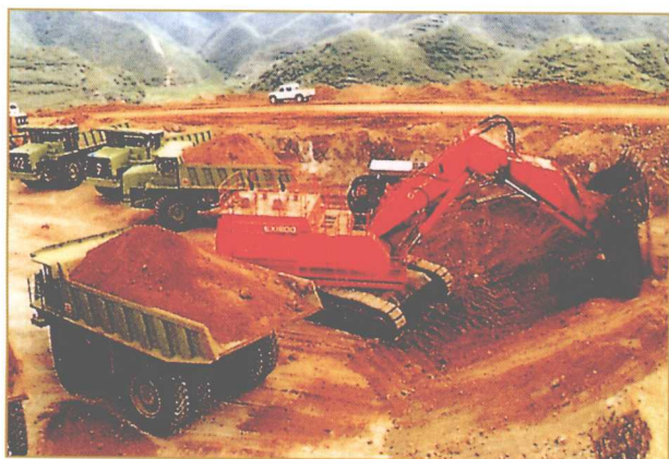
贵州宏福实业公司瓮福磷矿露天采矿场
