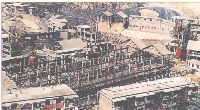
福泉磷肥厂年产25万吨钙镁磷肥装置
