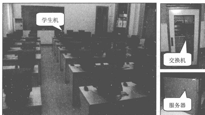
图 1.1 一个网络机房的组成
