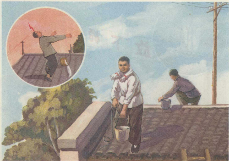
房顶上面有电线 电线离房七尺半
