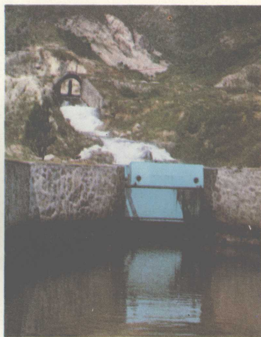
湖北省大悟县界 牌水库渠道上的后水 箱水力自动泄水闸。
