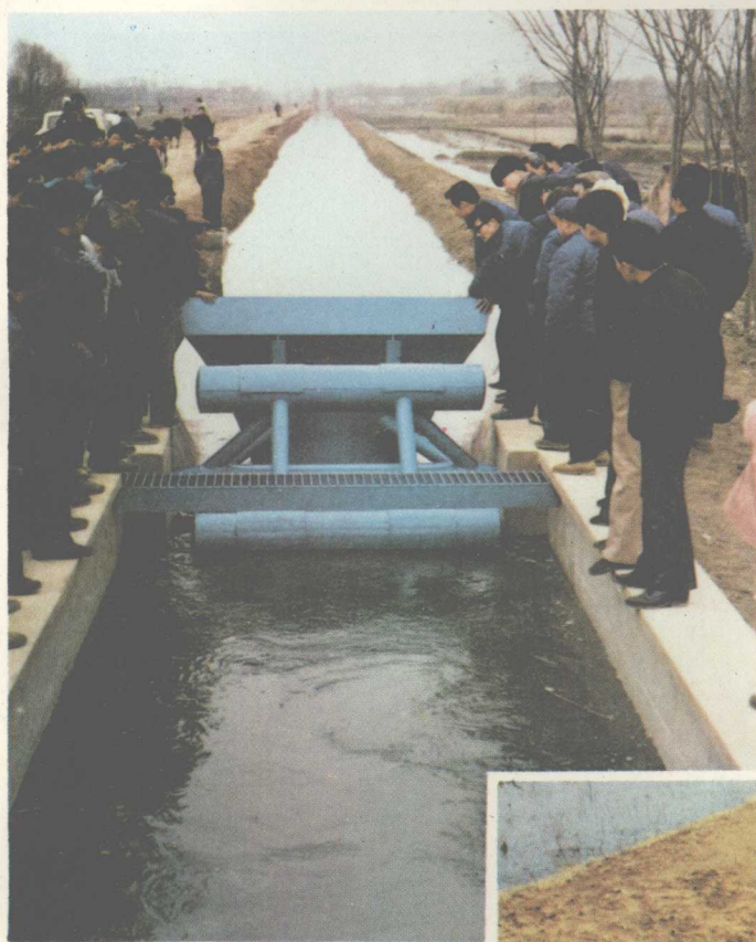
会议代表参观上游常水位控制水力自动闸门
