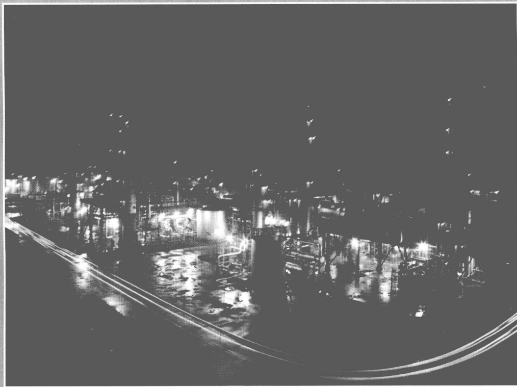
▼ 天然气净化厂
