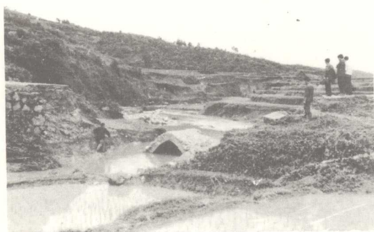
山洪冲毁香坪利朋桥现场
