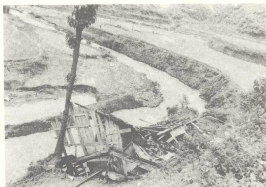
洞铁花桥水碾被洪水冲坏
