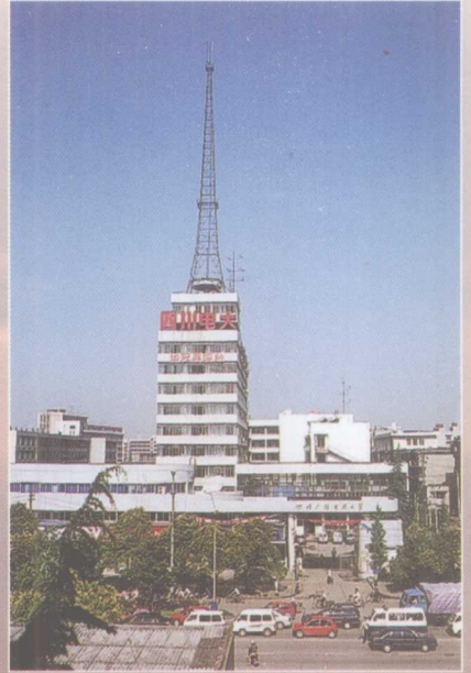
四川广播电视大学电教大楼
