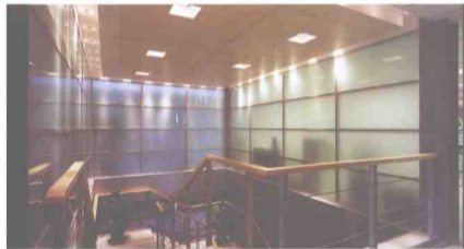
双层玻璃隔断墙
