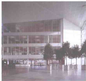
双层玻璃隔断墙
