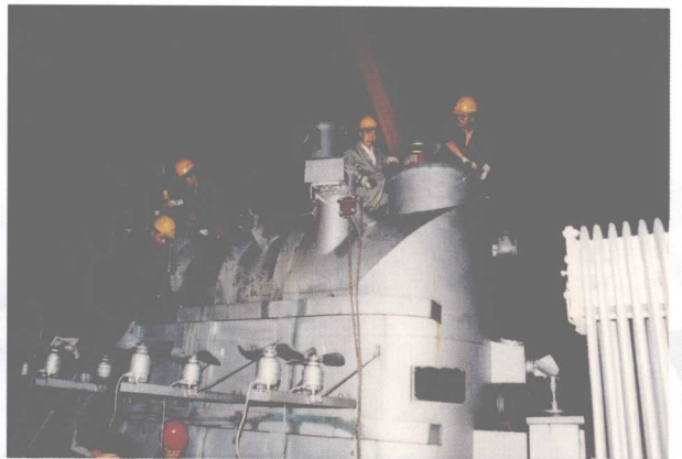
贵乌变电站夜间检修
