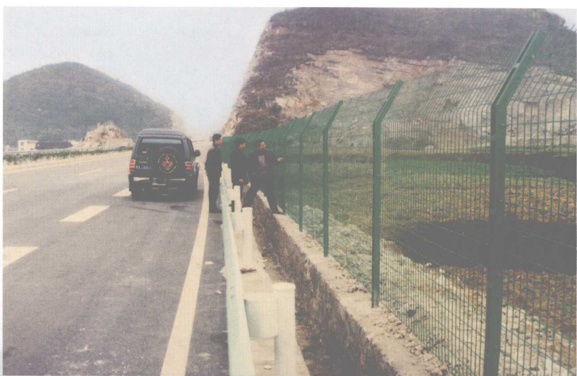
林东矿务局金属浸塑 厂制作并安装的贵新 公路防护隔离栏
