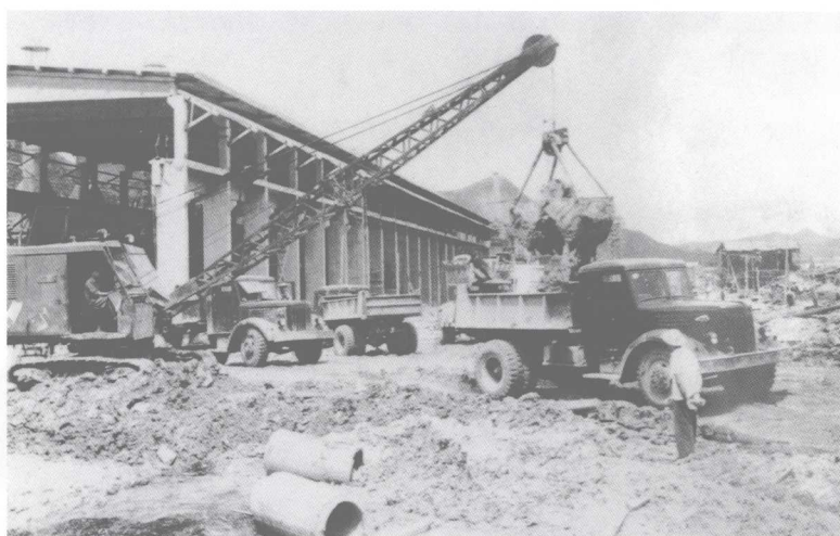
贵阳钢铁厂炼钢车间 (1959 年 6 月)
