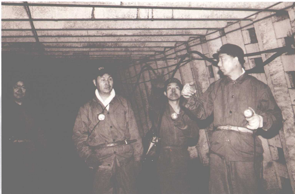
煤矿井巷检查
