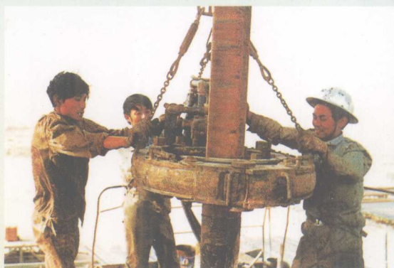
钻机安装作业
