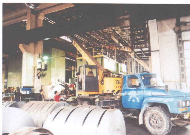
正在吊装作业的起重汽车
