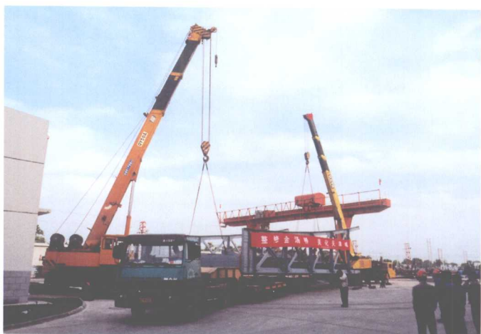
为金汤桥改造工程运输桥体
