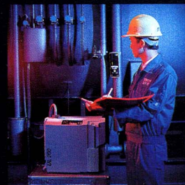
检漏及油漆车间 P130 - P135
