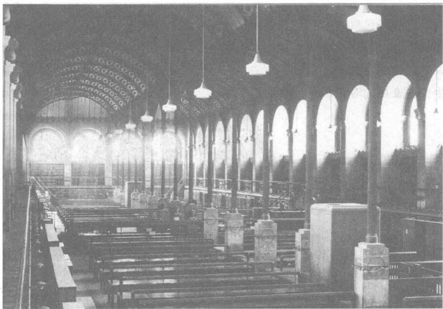
图3 十九世纪末设计未能相应地利用新材料的美感创造和谐的形式。此图是巴黎圣—热纳维耶芙图书馆由亨利·拉布鲁斯设计于1843—1850年。它公然显露铁框结构，而当时铁框一般覆以石料或者灰泥。
