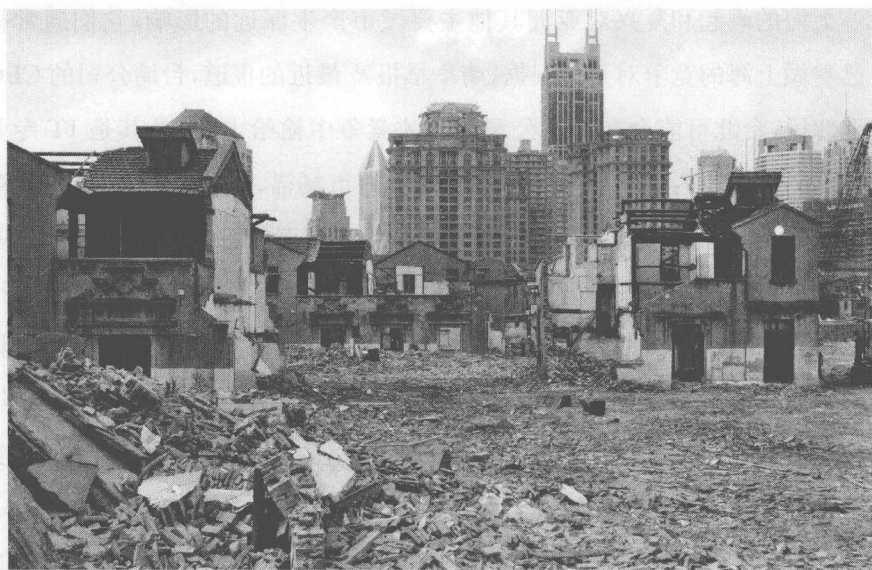
照片 0.2 上海拆除旧建筑,建设新建筑
