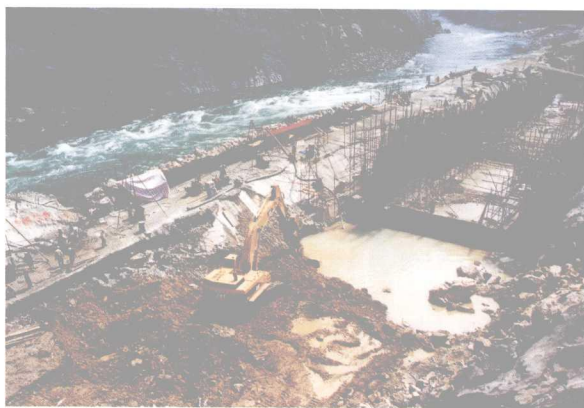
索风营水电站施工现场（龚宇、旷光彪 摄）
