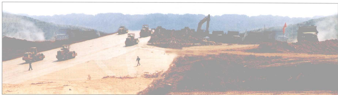
建设中的黎平机场（陈听怀 摄）
