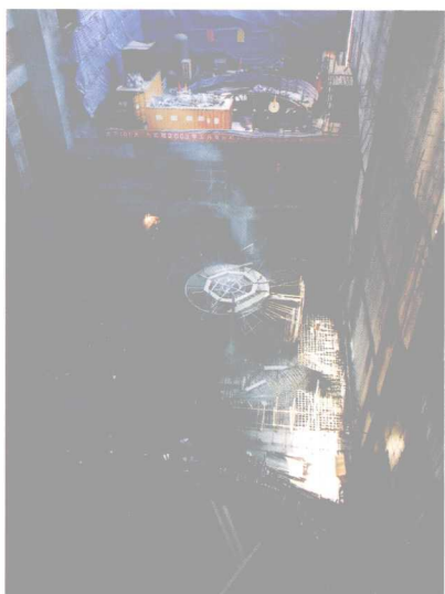
引子渡水电站建设已进入紧张安装阶段（张军焰 摄）
