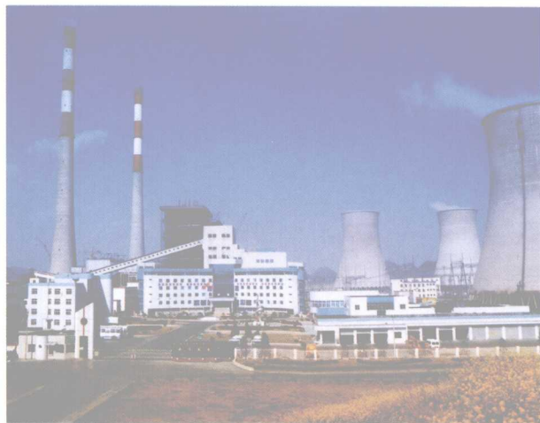
安顺发电厂全景
