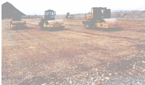
兴义机场动工以来，工程进展顺利。图为工程机械在压实主跑道基础（龚宇 摄）
