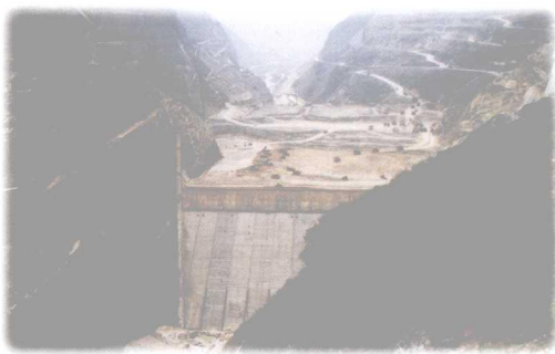
洪家渡电站大坝工程
