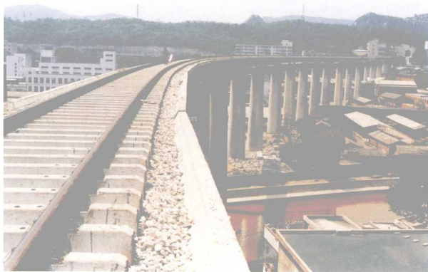
株六复线贵阳南明河铁路大桥于2002年8月28日顺利铺架成功。该桥是贵阳枢纽控制性工程，标志着贵阳枢纽建设取得进展（旷光彪 摄）
