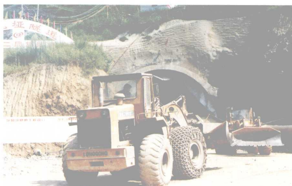
全长117.9千米的遵义至崇溪河高速公路前期工程近开工。图为中铁十二局职工在开挖桐梓凉风垭隧道（龚宇 摄）
