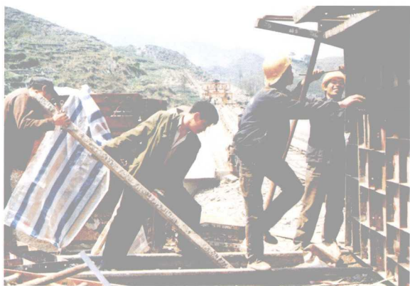
水城至黄果树高等级公路开工一年来，现已进入路基兴建、桥梁架设和隧洞开挖阶段。图为工人在六枝架桥（龚宇 摄）
