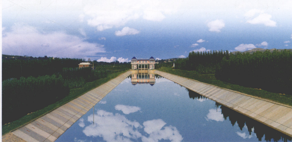
南水北调东线第一个建成的单项工程——济平干渠
