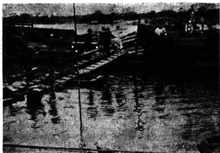
裝接過河水管 ↓
