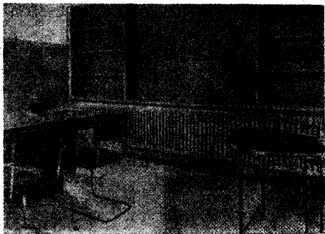
图 6 單排壁板散热器
