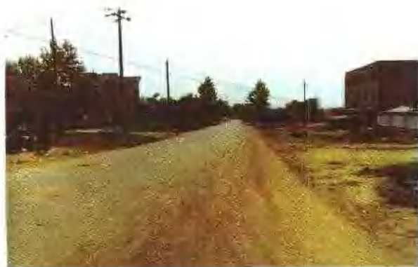
我市自力筹建的鄂黄公路路基 (市公路段供稿)
