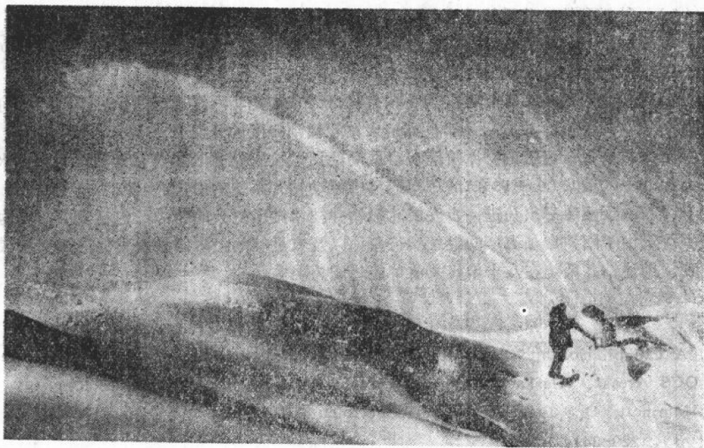
图10 在埃克森公司的冰岛上喷洒造冰(阿拉斯加波弗特海, 1979年3月)
