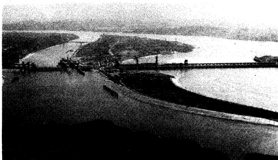
举世瞩目的葛洲坝水利工程
