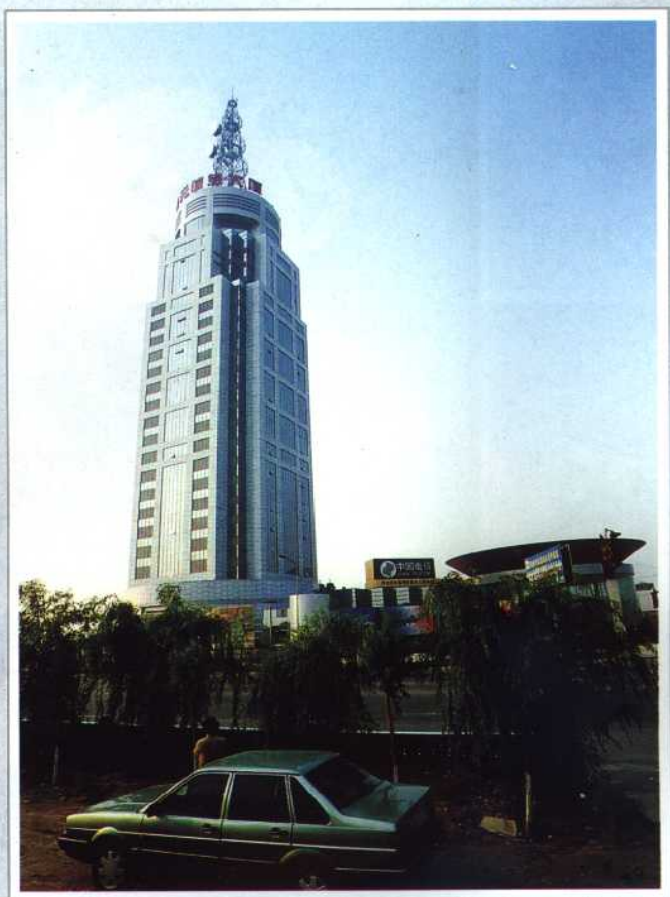
加大投资拉动。图为投资1.2亿元的省重点项目——邢台通讯枢纽大楼竣工
