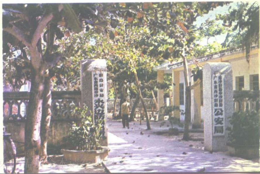
山枇杷树掩映下的广东省西沙群岛南沙群岛中沙群岛公安局 (黄克淮摄)
