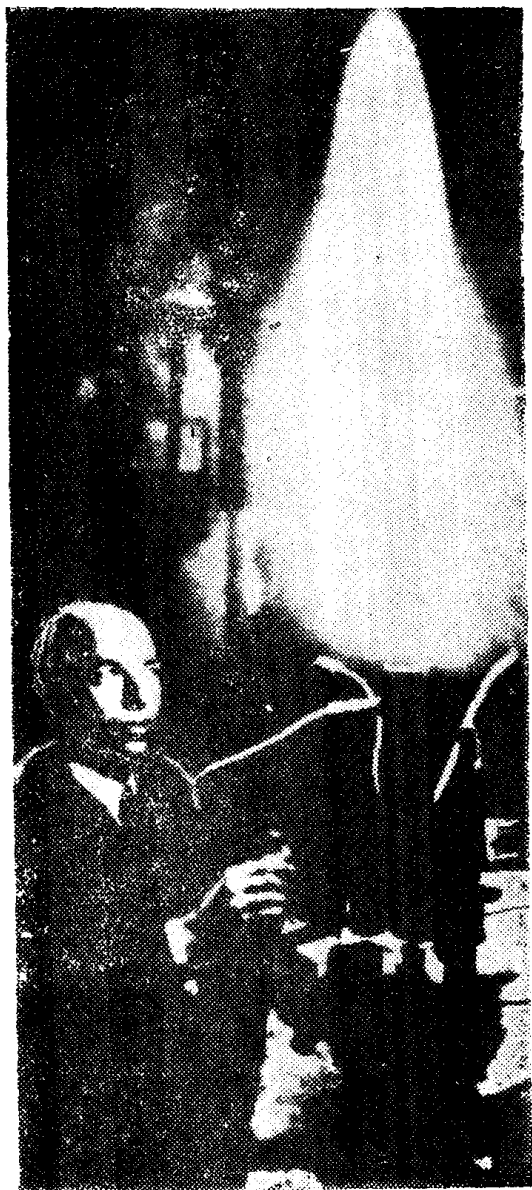
图1-4 马克斯·瓦利尔，德国工程师，首先研究固体燃料火箭装入赛车和冰橇，后来转而研究液体推进剂。图中，他正在海兰特工厂的工作台上进行液体发动机的点火试验。
