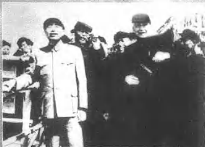
周恩来总理(左一)视察三门峡水利枢纽工程时，汪胡桢总工程师(右一)向总理汇报施工情况。
