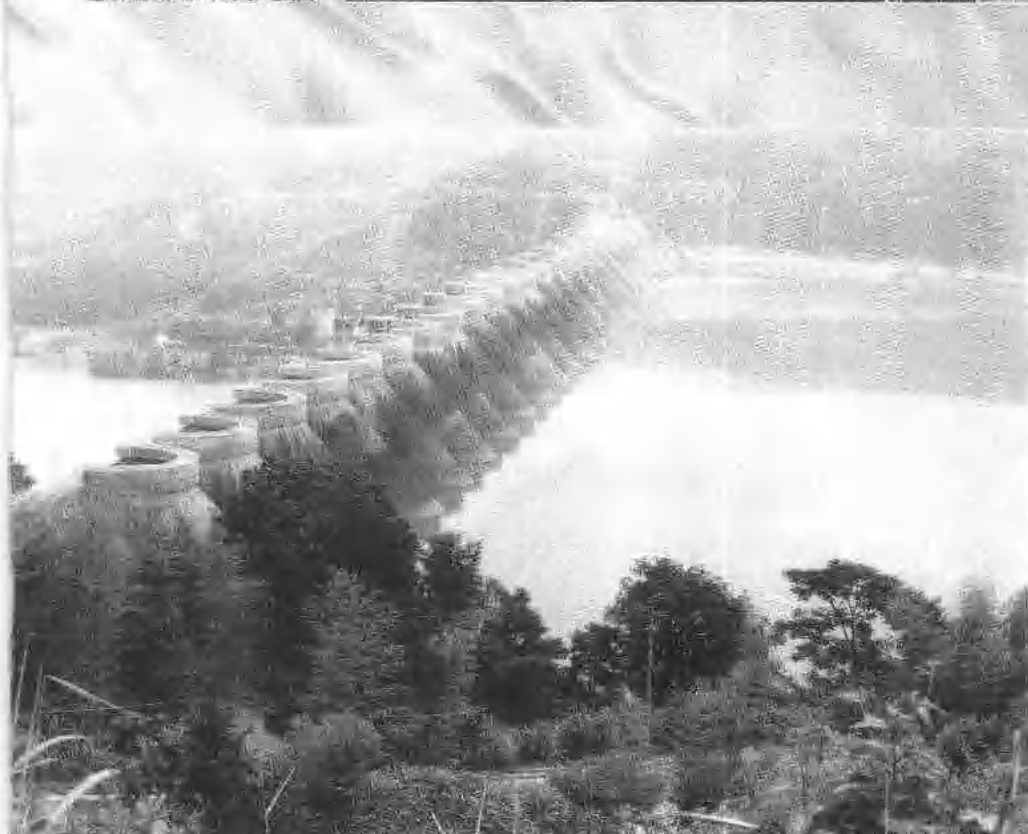
佛子岭水库工程于1932年1月开工兴建，至1954年11月竣工。水库大坝为钢筋混凝土连拱坝，由21个拱、20个垛及两端重力坝(西端有一段为平板坝)所组成。最大坝高为74.4米，坝顶全长为510米。图为佛子岭水库全景。
