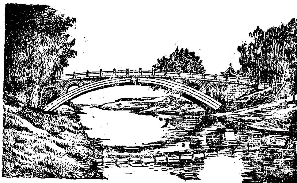
图1-1-2 河北赵县赵州桥（公元605年）
