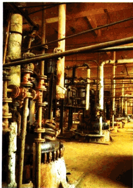
万吨立德粉生产车间
