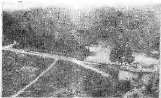
分水水库 有效库容525万立方米，灌溉面积1.76万亩。
