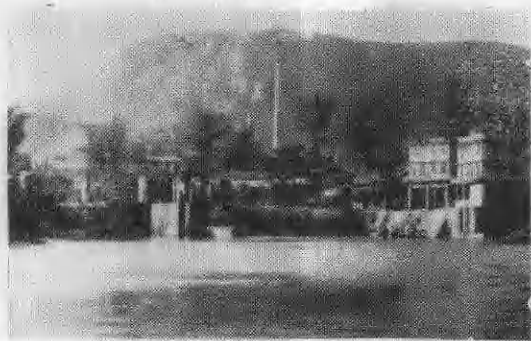
蟠龙水轮泵抽水站 安装水轮泵18台，灌溉面积3.48万亩。
