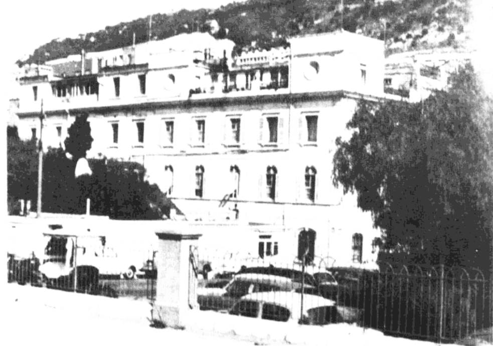
直布罗陀城中的布里斯托尔旅馆，背靠巨岩，俯瞰海湾；
