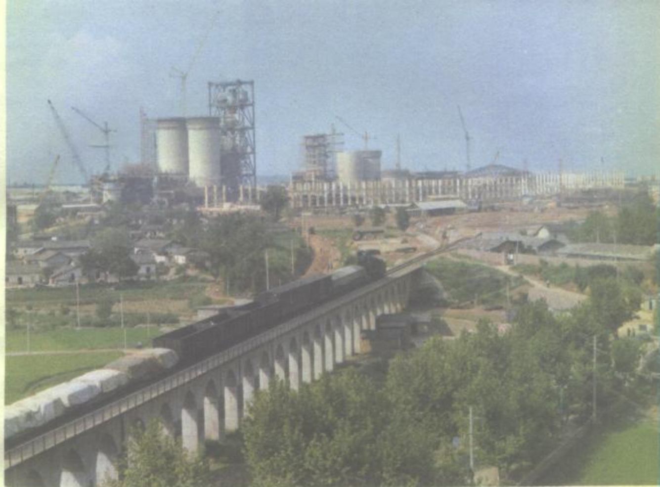
兴建中的宁国水泥厂
