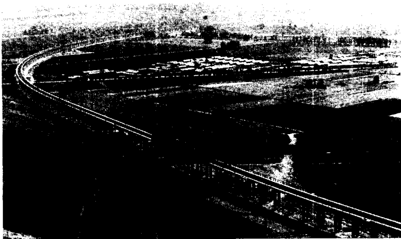
图为第三工程局修建的跨越京广线的新（乡）荷（泽）铁路上的一座特大桥，全长3,016米。
