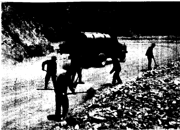
新疆公路上的工人在养路
