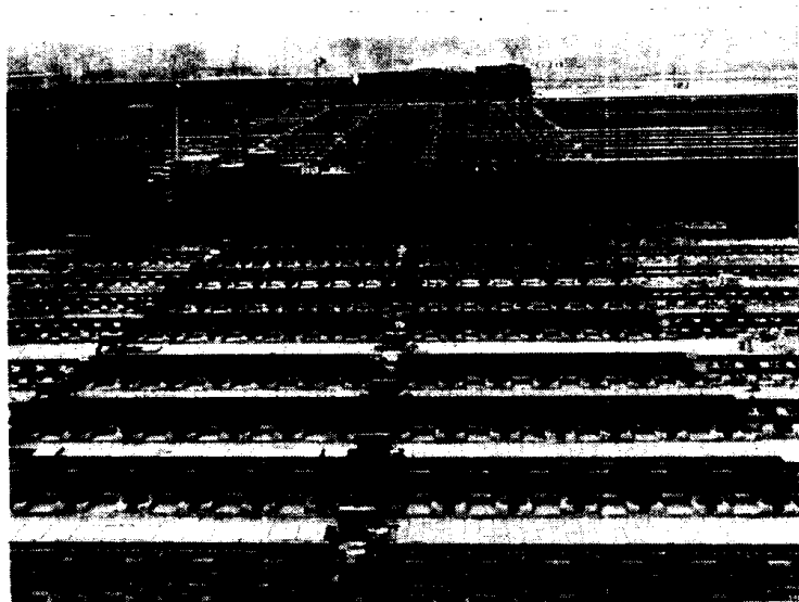
郑州北站上行编组场三十二条股道上安装的第三制动位
