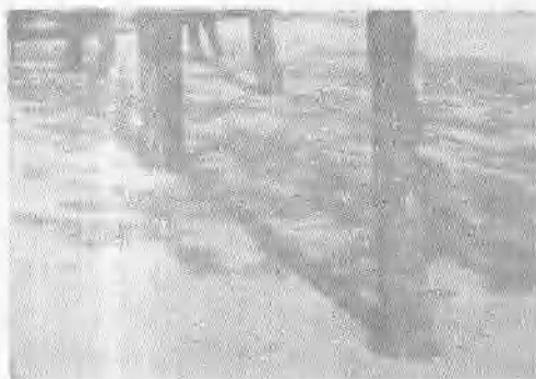
地面铺装到树木根部，使雨水没有渗透的余地。
