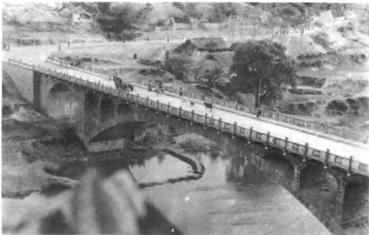
新建的乐运大桥。
