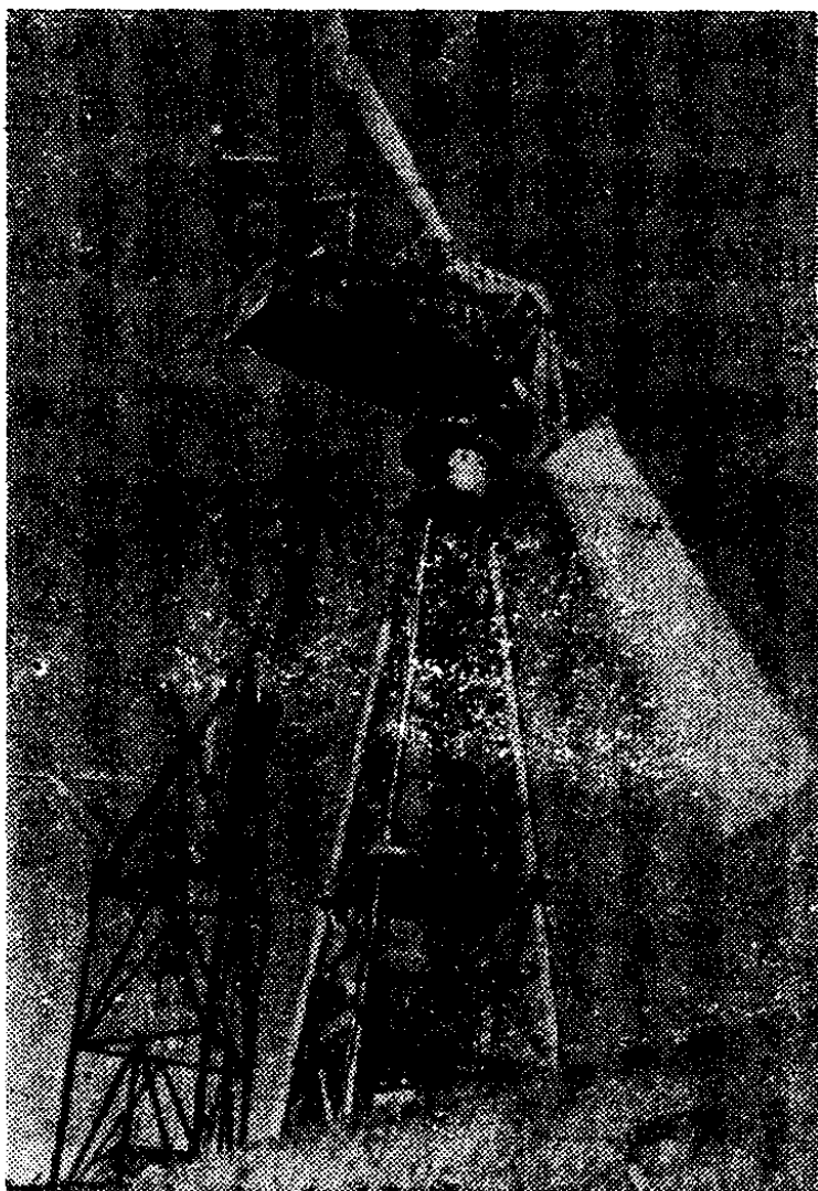
二次世界大战期间，其额定功率为1,250千瓦的为弗蒙特电网供电的巨大的史密斯-普特南风力发电机
