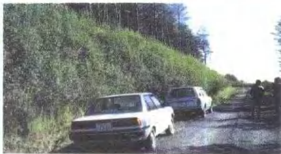
图片 1.14 采用播种工程实践早期绿化实例(1) 毛赤杨,施工 3 年后群落外貌(农用地质备公园东北支社境内)。
