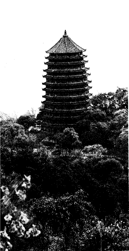
钱塘江畔一巨塔——六和塔
