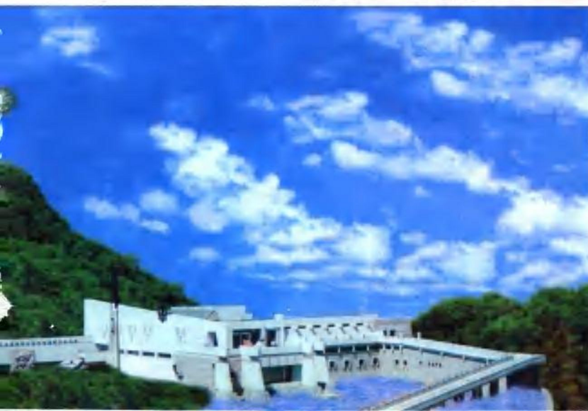
镇海口海防历史纪念馆全貌
