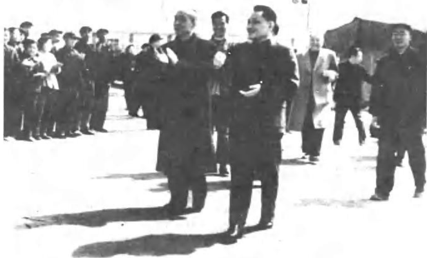
1964年邓小平、李富春同志视察刘家峡电站修建工程
