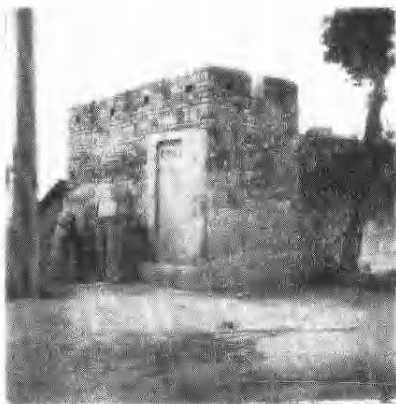
郎溪古城 墙一隅。郎溪 古城墙建于明 嘉靖四十五 年（公元1566 年），现已 420年。上为 东南一隅。
