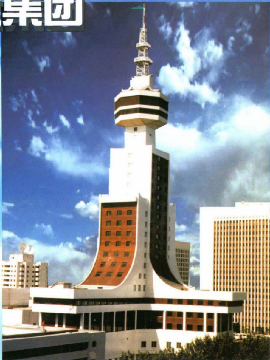
北京电视台直播中心（获国家鲁班奖工程）
