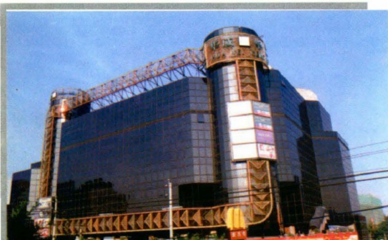
西单购物中心（华威大厦） 总建筑面积70000平米， 地下三层，地上十一层。
