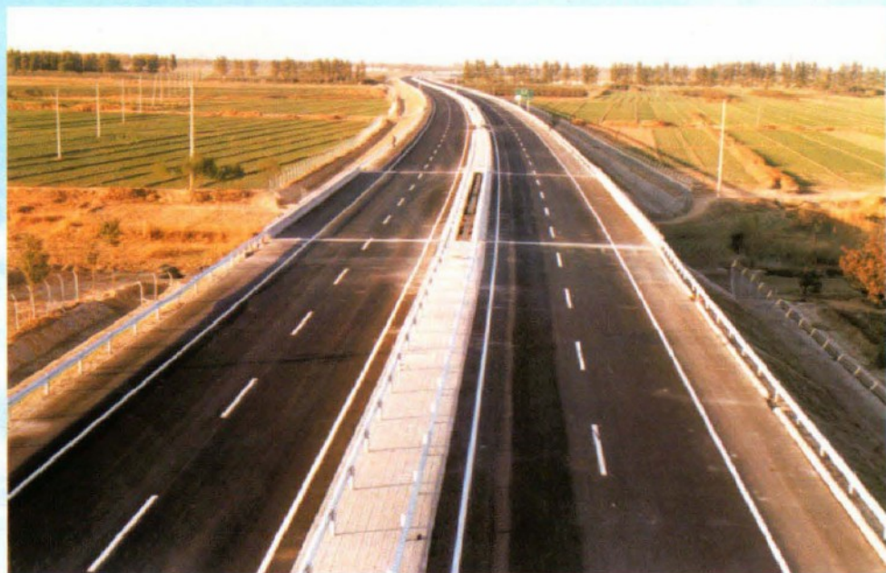
济德高速公路
