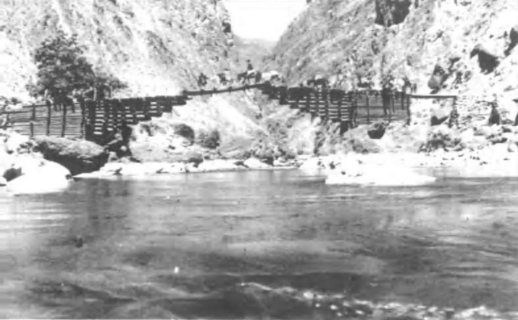
历史悠久的伸臂桥
