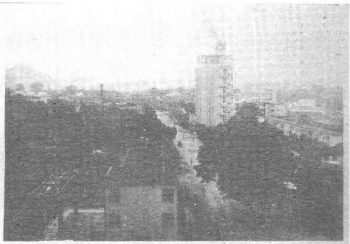
钟山县电视大楼
