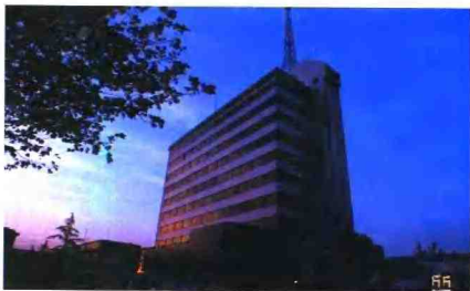
交警支队指挥中心大楼
