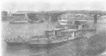
武汉市石油公司汉 阳月湖水上加油站
