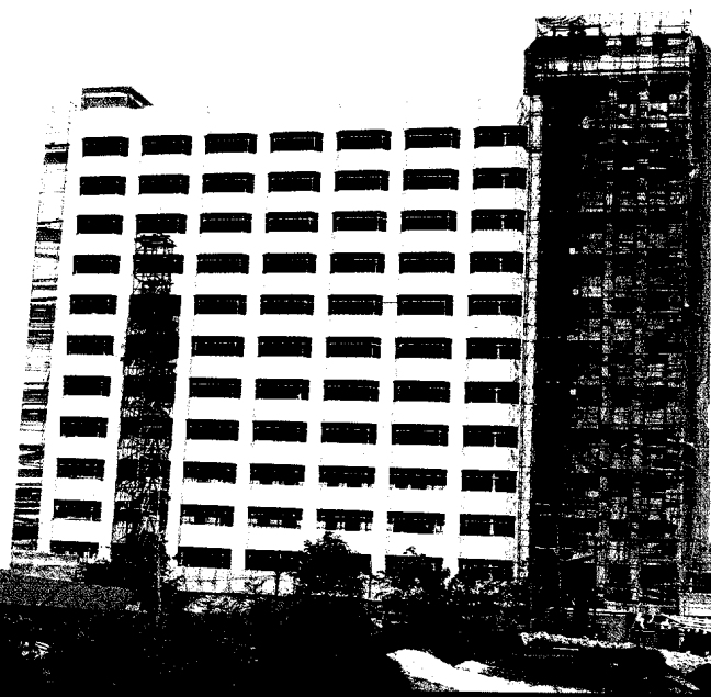
正在建设中的科研主体大楼
