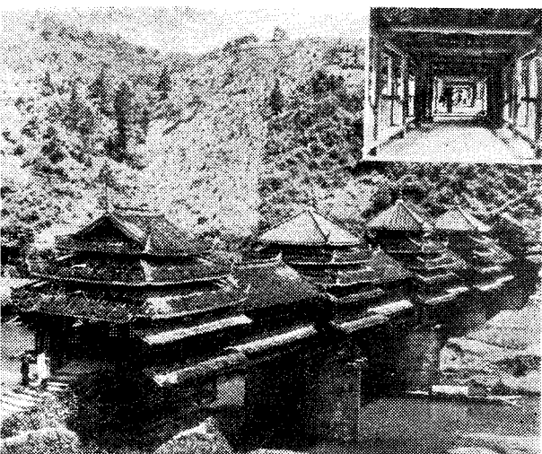
广西程阳永济桥
